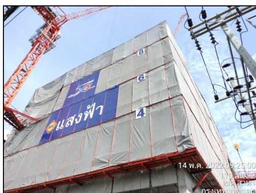
ภาพที่ 10 ติดตั้ง Mesh Sheet
