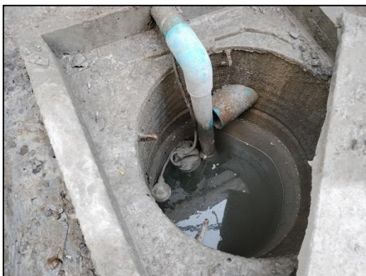
ภาพที่ 39 ป้อนน้ำและท่อสูบน้ำขึ้นใต้ดิน
